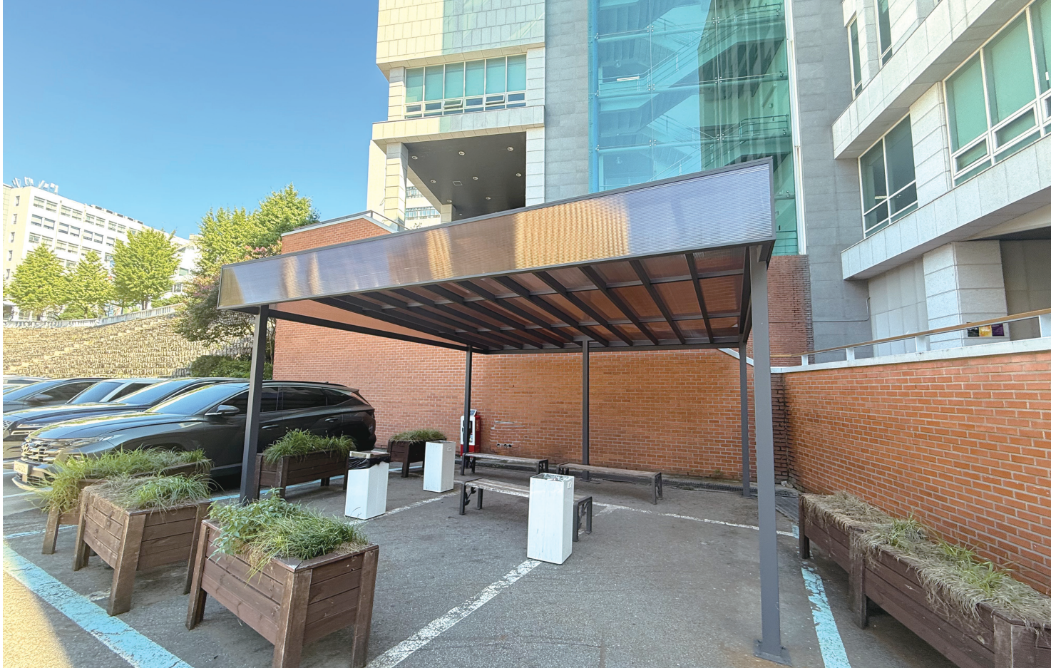
노천극장 주차장에 개방형 흡연부스가 설치됐다.
